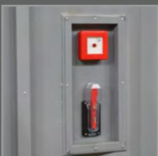
**Кнопка аварийного отключения** аварийный останов и перекрытие подачи топлива
