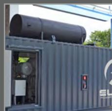
**Глушитель на крыше** снижает шум выхлопа двигателя
