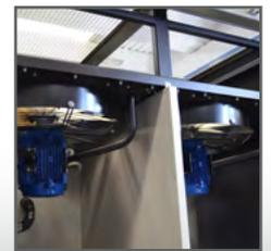
**Модель 70 EDR\*** выносной радиатор с вентилятором
