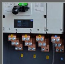
**Медные шины** позволяют подключать больше кабелей к одной фазе
