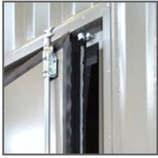
**Уплотнительная прокладка на дверце** обеспечивает плотное прилегание дверцы и снижает уровень шума
